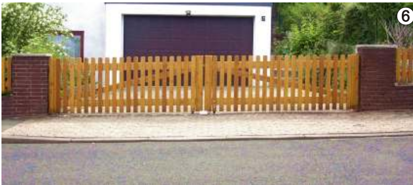
Vorderansicht Doppeltor ca. 500 cm breit auf Rolle laufend! (auf Neigung gefertigt!)
