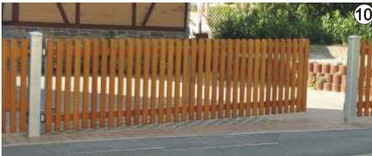
Tor Außenansicht (von Bild 9). Kein Stahlrahmen sichtbar! Das Tor wurde dem Gefälle im Zaunverlauf angepasst!
