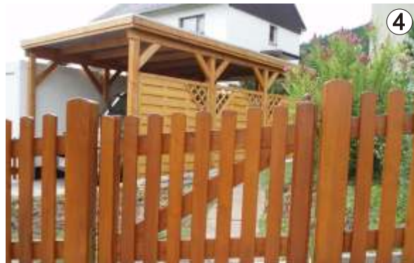
Holzzaun kombiniert mit Aluminiumpfosten (Zaun auf Neigung gefertigt).
