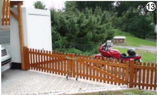
Tor Außenansicht (von Bild 9). Kein Stahlrahmen sichtbar! Das Tor wurde dem Gefälle im Zaunverlauf angepasst!
