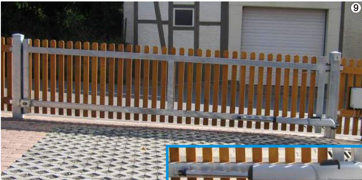
Drehflügeltor ca. 400 cm breit mit Holzbelattung und Torantrieb. Das Tor wurde dem Gefälle im Zaunverlauf angepasst!
