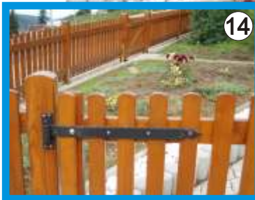
Beschläge aus Schmiedeeisen außen angebracht!
