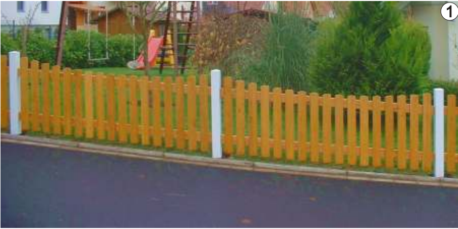
Holzzaun kombiniert mit Aluminiumpfosten (Zaun auf Neigung gefertigt).
