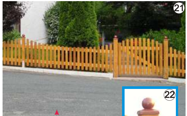
Zaun Sylt mit Pforte! Hierbei ist der Zaun auf Neigung, die Pforte aber in waage gefertigt
