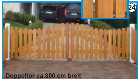
Zaun Sylt mit Pforte! Hierbei ist der Zaun auf Neigung, die Pforte aber in waage gefertigt
