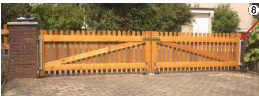
Rückansicht Doppeltor ca. 500 cm breit auf Rolle laufend! (auf Neigung gefertigt!)
