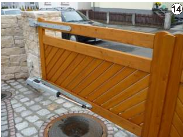
Doppeltor von der Rückseite mit Torantrieb.
