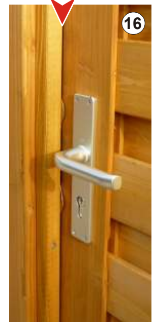
Tür mit Diagonalverstrebung und Einsteckschloß mit Drücker und Pz.
