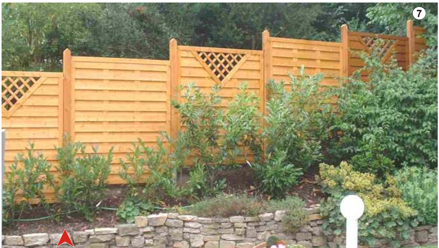
Im Wechsel mit V-Ausschnitt und ganz geschlossen, abgestuft im steigenden Gelände
