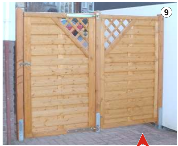
Durchgang zwischen Haus und Garage 1 Element fest und eine Tür
