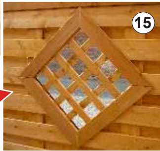
Terrasse direkt an der Straße gelegen (ohne Sichtschutz nicht zu nutzen). Rauten mit Rankgitter Sprossenabstand 10 cm Sprossen 14x35 mm V2A verschraubt.
